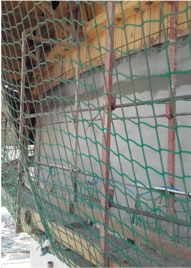
Abbildung eines Hängebühelgerüsts
